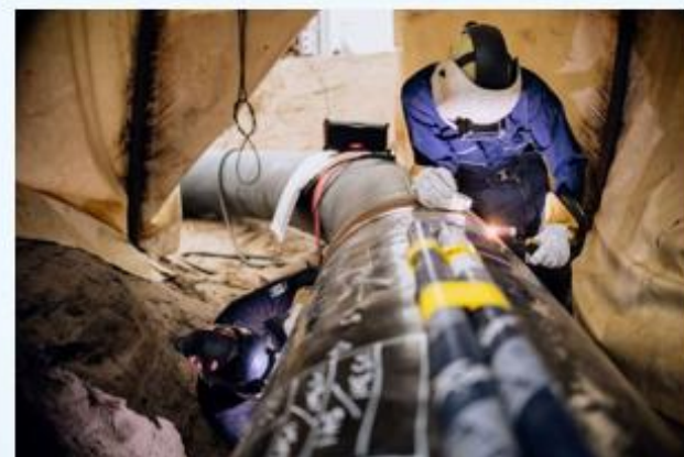
Construction H 2 pipeline (© Gasunie)
